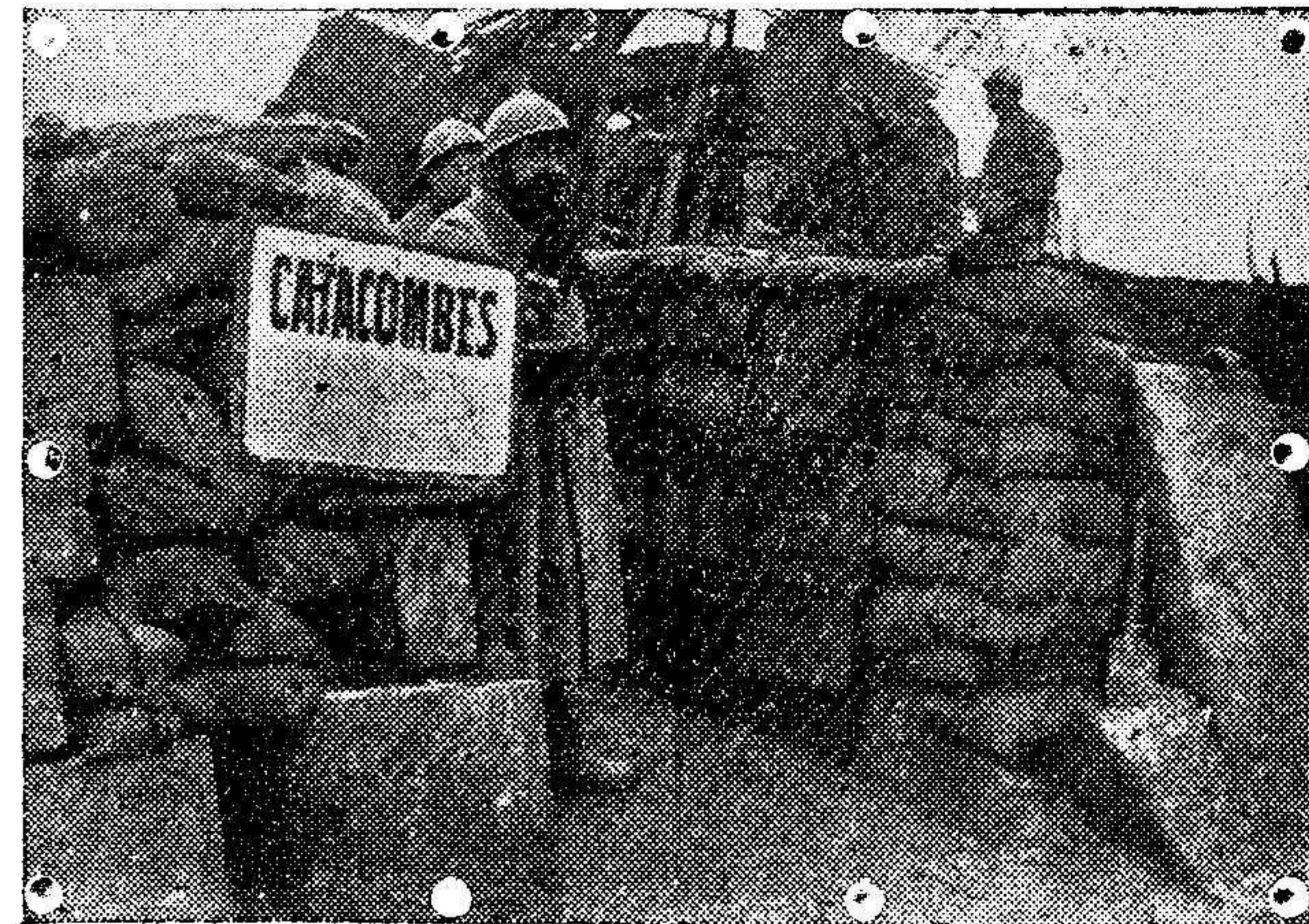
EN EL SOMME.—ENTRADA DE UNA TRINCHERA LLAMADA DE LAS CATACUMBAS
