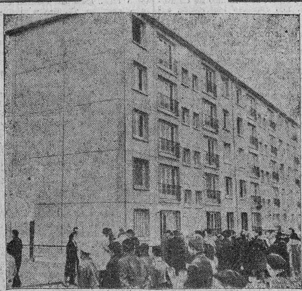
He aqui un record mundial en la construcción de edificios. La casa de la foto ha sido levantada en veinticuatro dias, en la localidad francesa de Asnieres. Nueve de ellos se emplearon en la superestructura de los elementos prefabricados-
