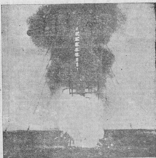
El primer intento de lanzamiento. El «Vanguard» se elevó sólo unos metros portando el satélite para fracasar estrepitosamente. Un fallo del mecanismo originó el fracaso. La llamarada que se ve en la foto se agigantaría más aún después con la explosión del proyectil.
