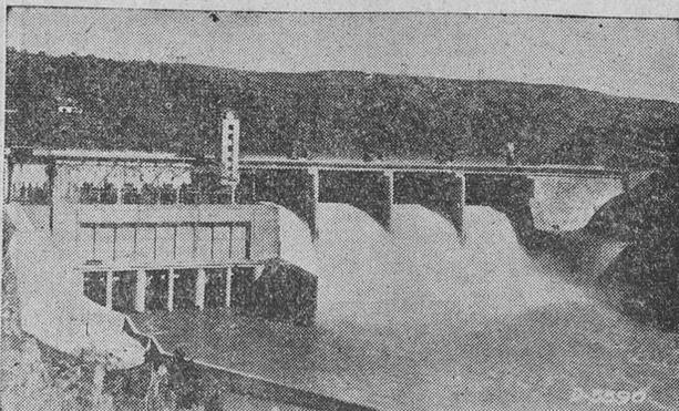
Salto de Villacampo. La presa vierte por su aliviadero de superficie el sobrante del embalse. La central, compuesta por tres grupos generadores, con un total de 134.350 CV de potencia, produce anualmente 360 millones de Kv.
