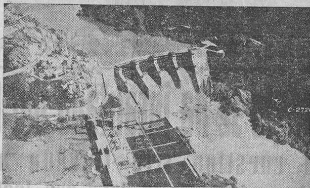
El Salto de Castro, situado donde el río Duero empieza a ser frontera con Portugal, también desagua el sobrante de su embalse por el aliviadero de superficie. La central, con una potencia de 119.400 CV, produce anualmente 320 millones de Kv.
