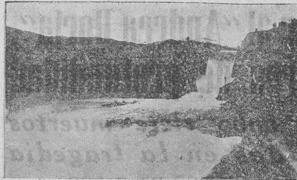
El gran aliviadero del Salto del Esia tiene una capacidad de desagüe de 5.000 metros cúbicos por segundo. Lo vemos desagüando sólo 1.000 metros cúbicos por segundo por el de superficie (al fondo) y 800 metros cúbicos por segundo por el túnel, del que se ve la salida en el primer término de la fotografía.
