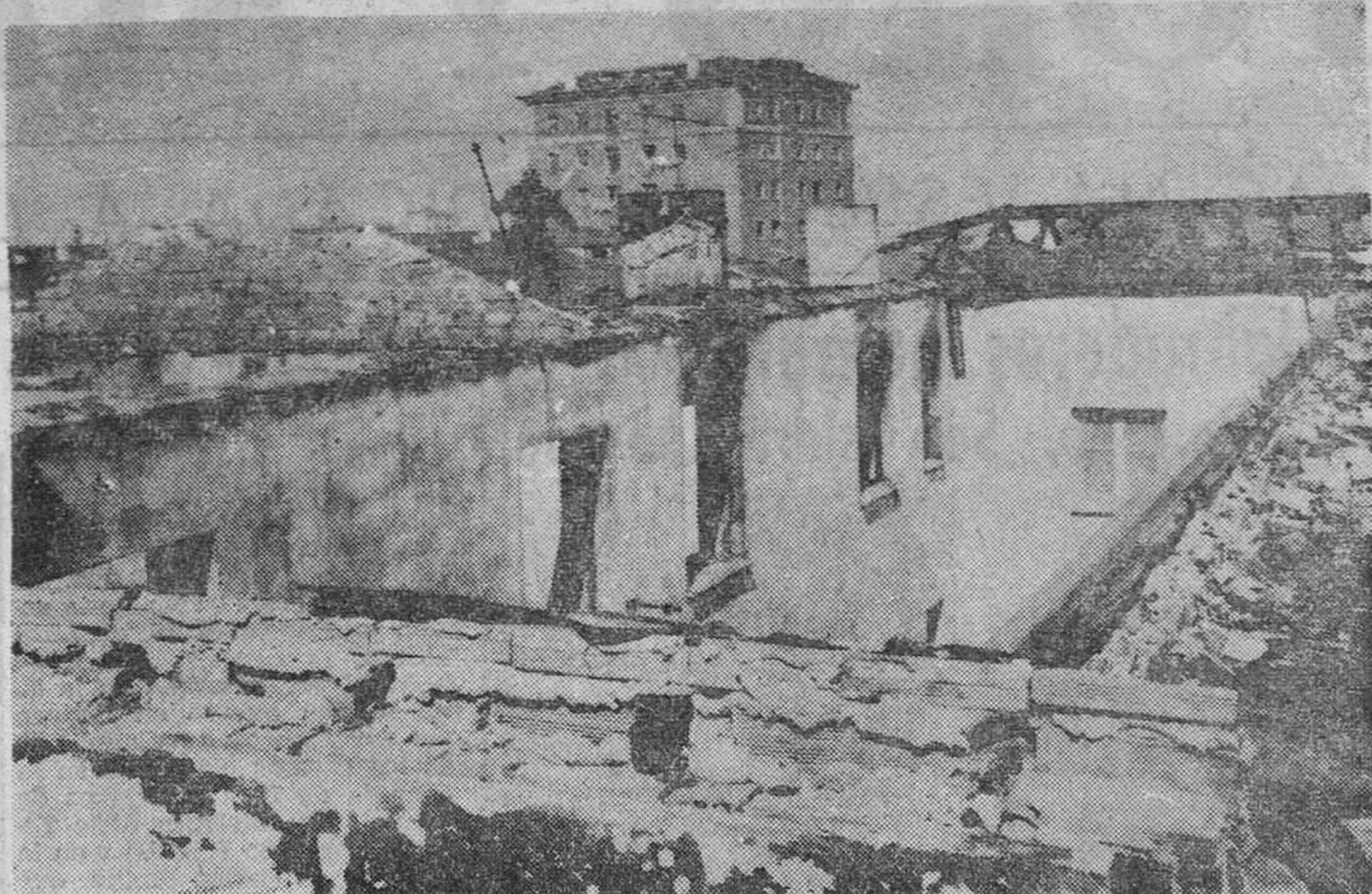
ESTADO EN QUE QUEDO LA CUBIERTA
