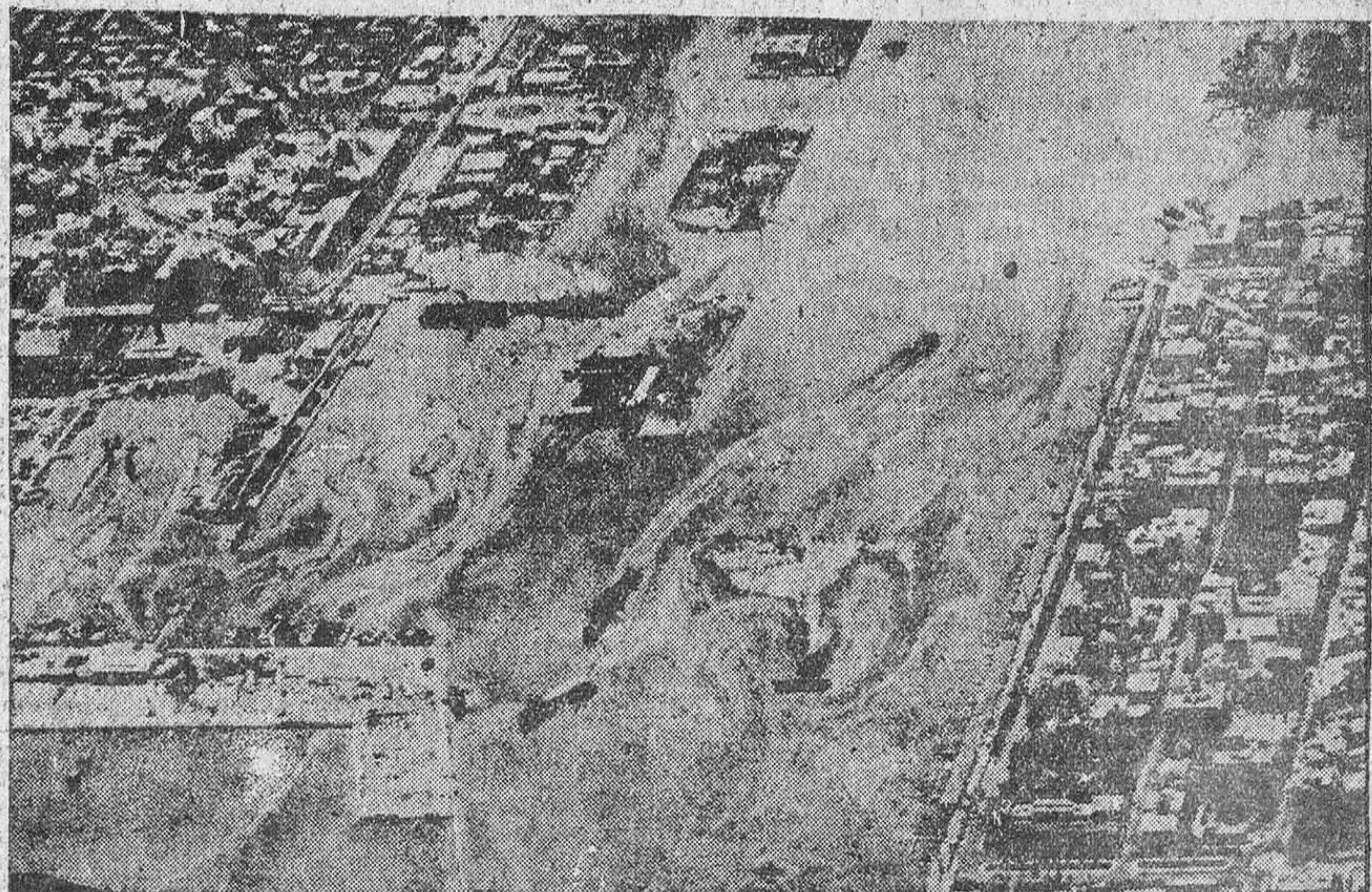
Esta fotografía aérea da idea de la situación en que se encuentra el Canal de Suez, lleno de barcos hundidos y con las huellas del carburante vertido sobre las aguas. Pasarán todavía varios meses antes de que pueda recobrar su situación normal.
