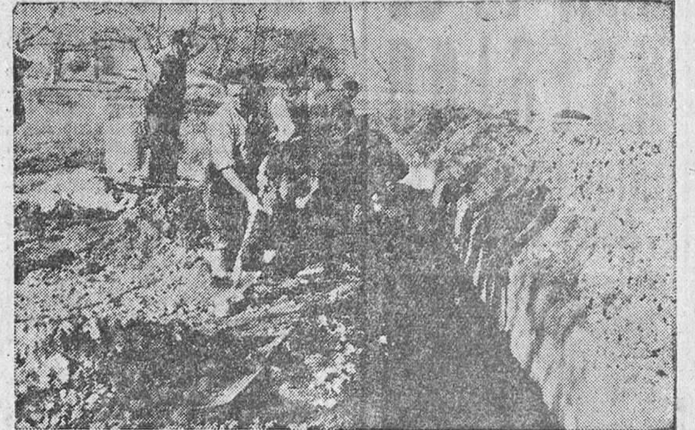
Los obreros trabajando en la tubería de desagüe.—(Foto Juanes.)
