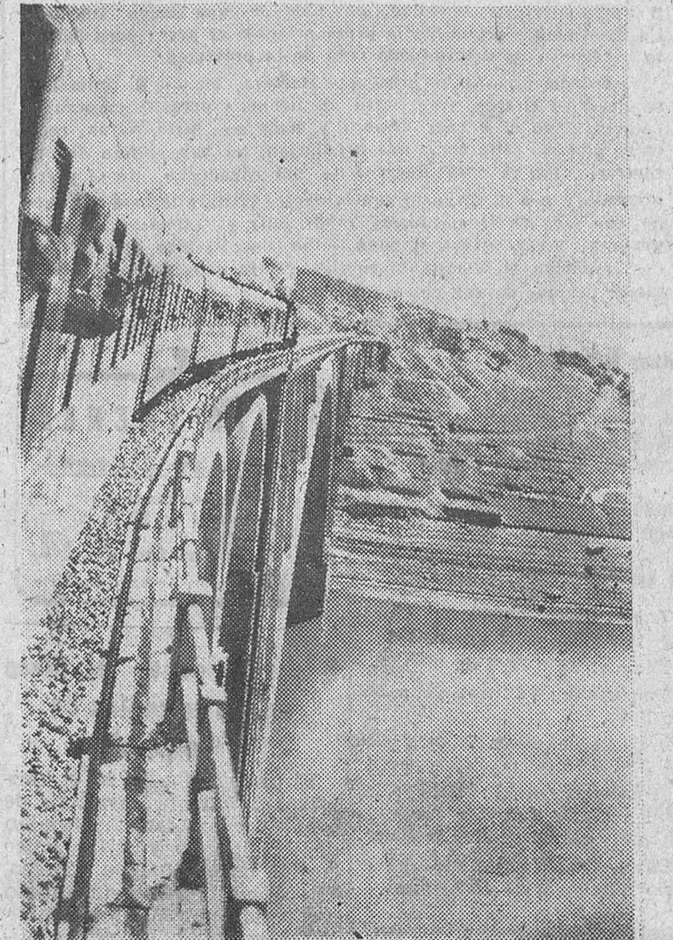
A su paso por la dehesa de Mázares, entre las estaciones de Andavías y Carbajales de Alba, el ferrocarril de Zamora a Puebla ofrece al viajero esta bonita perspectiva. Bajo los arcos del viaducto, un inmenso lago azul se extiende ante la mirada. Los viajeros se asoman a las ventanillas un poco asustados, pensando quizá en un imaginario «salto del ángel» que podría hacerse sobre las aguas serenas del embalse.
