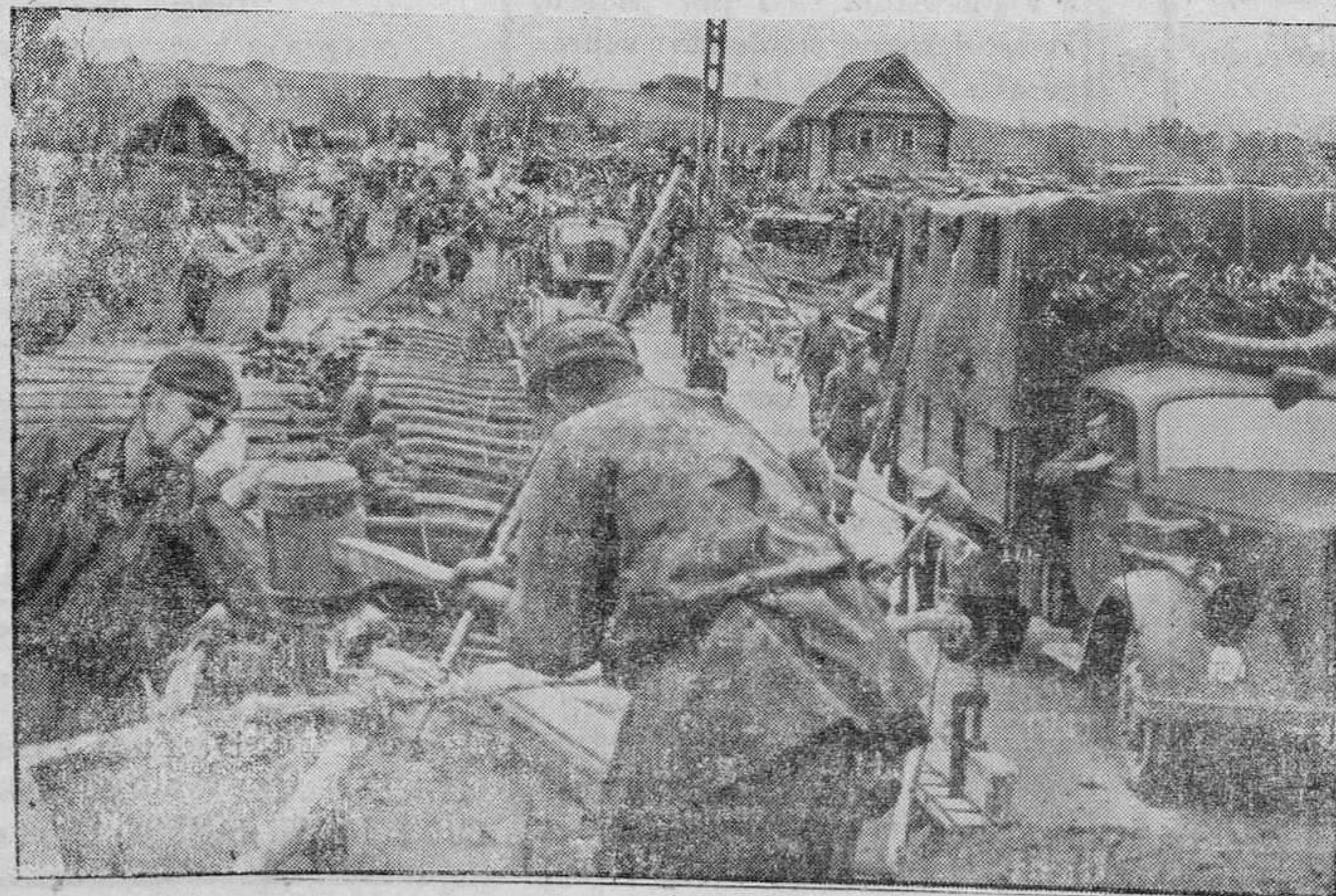
Zapadores de la SS militarizada construyendo un puente auxiliar para el paso de tropas y material.
