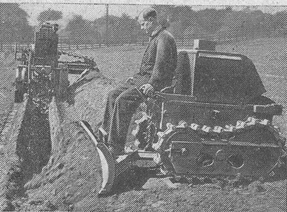
Tractor con motor Diesel que realiza el trabajo de diez hombres manejado por una sola persona y con gran facilidad se utiliza con rendimiento en los trabajos de allanamiento y explanación, así como para retirar los escombros de los edificios destruidos por bombardeos en las ciudades británicas.
