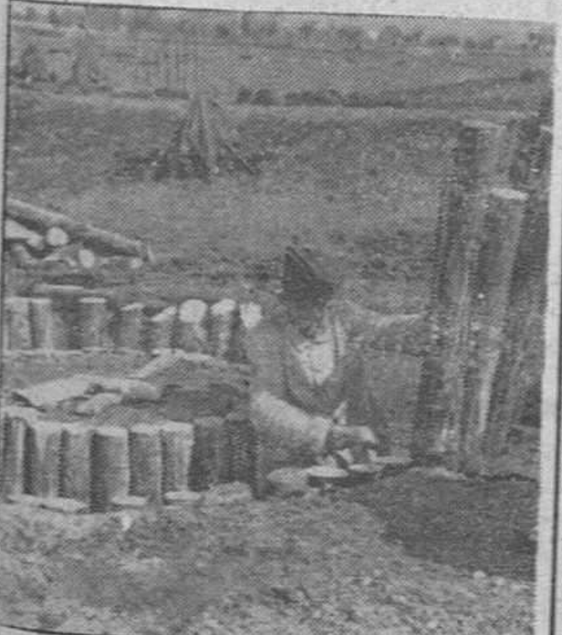
Joven alemán del servicio de trabajo construyendo un fortín para un puesto de ametralladora
