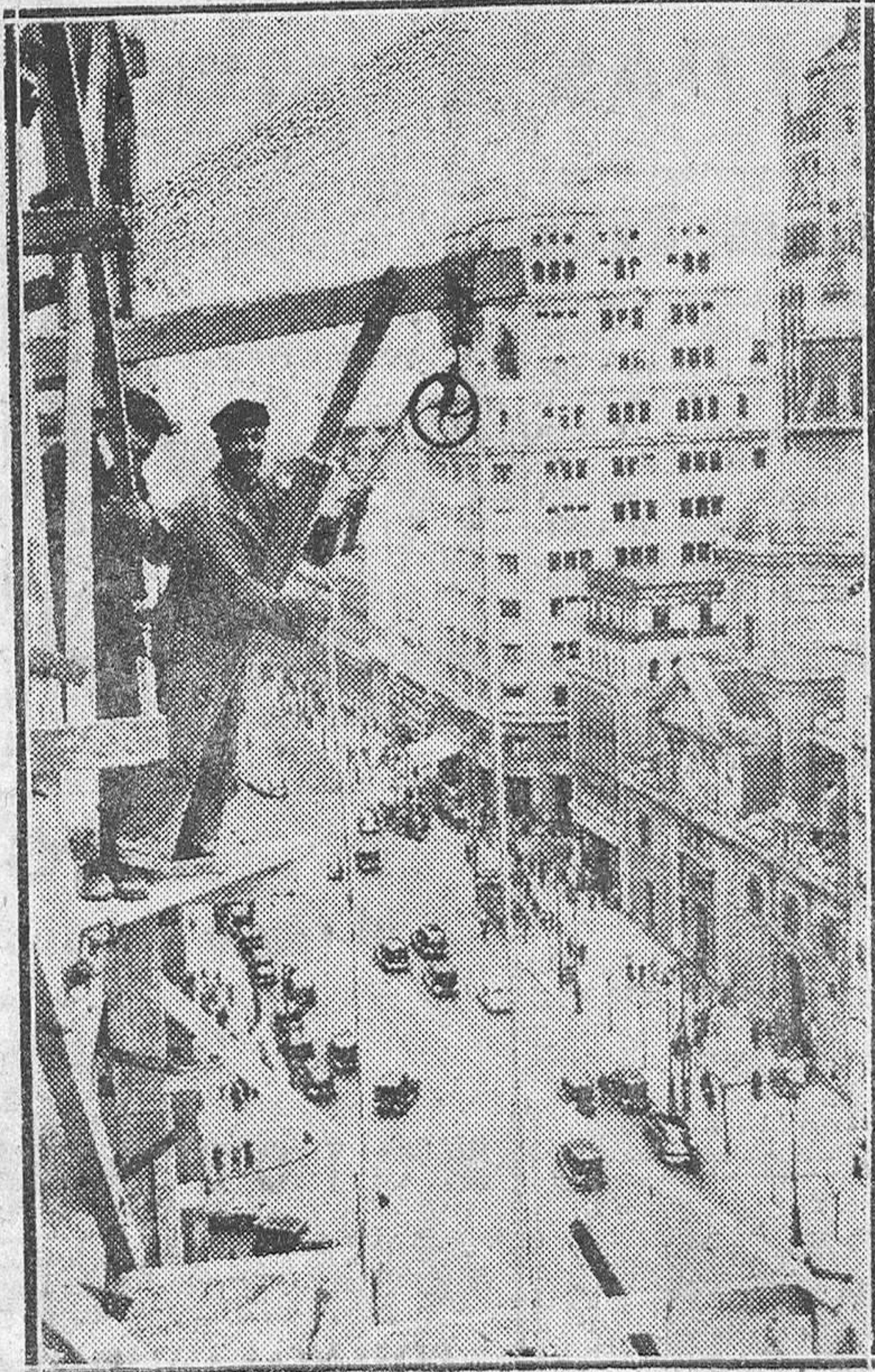
Ahi tienen ustedes cómo se ve la calle de Alcalá desde el andamiaje que se ha montado en el Ministerio de Educación para reparar su fachada. El tal andamiaje alcanza una altura de cincuenta y dos metros, pesa setenta toneladas y ha precisado cien metros cúbicos de madera de pino. Eso sin empezar el retoque.
