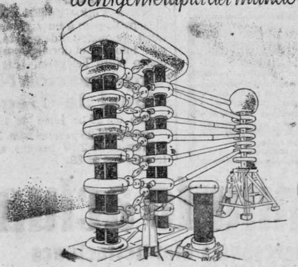
se halla en Hamburgo, construida por SIEMENS REINIGERWERKE, Berlin. El gigantesco aparato es capaz de sostener en servicio permanente una tensión continua constante de un millón de voltios. Para igualar sus efectos mediante radium serían precisos 10 kilos por valor de 400 millones de dólares.
