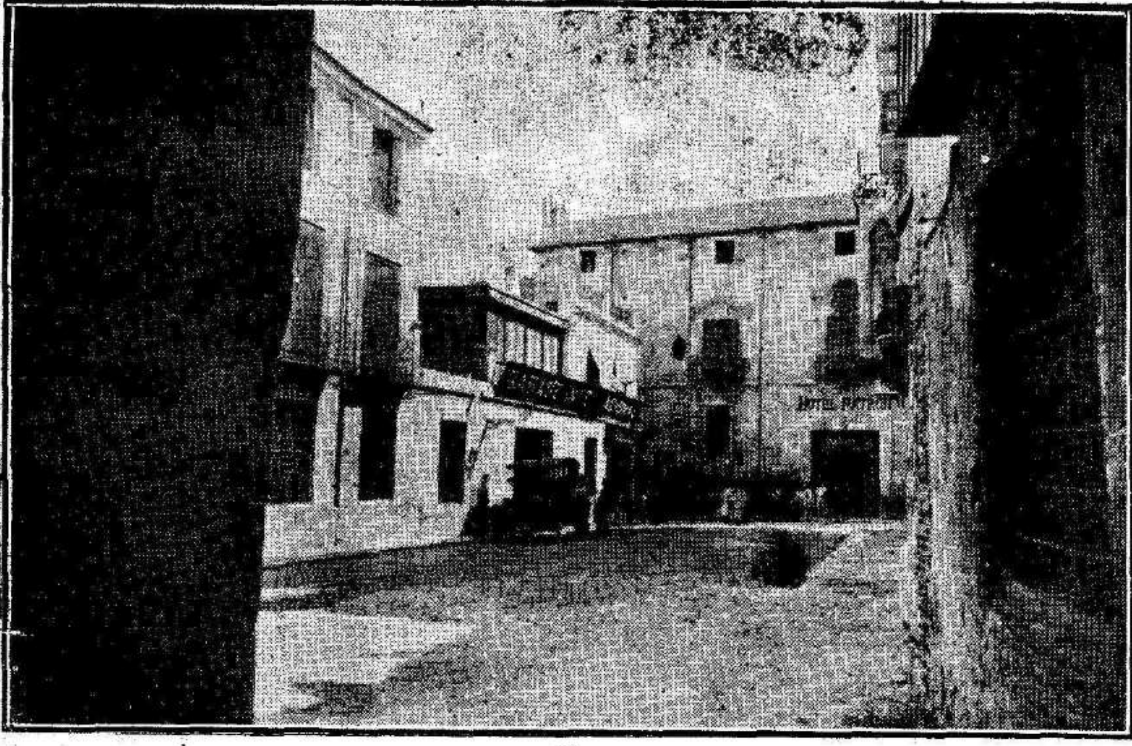
Con la demolición en la calle de Villaleal de una casa en forma de martillo, situada a continuación de la ventana que se vé en primer término se da una nueva entrada de carruajes al centro de Murcia
