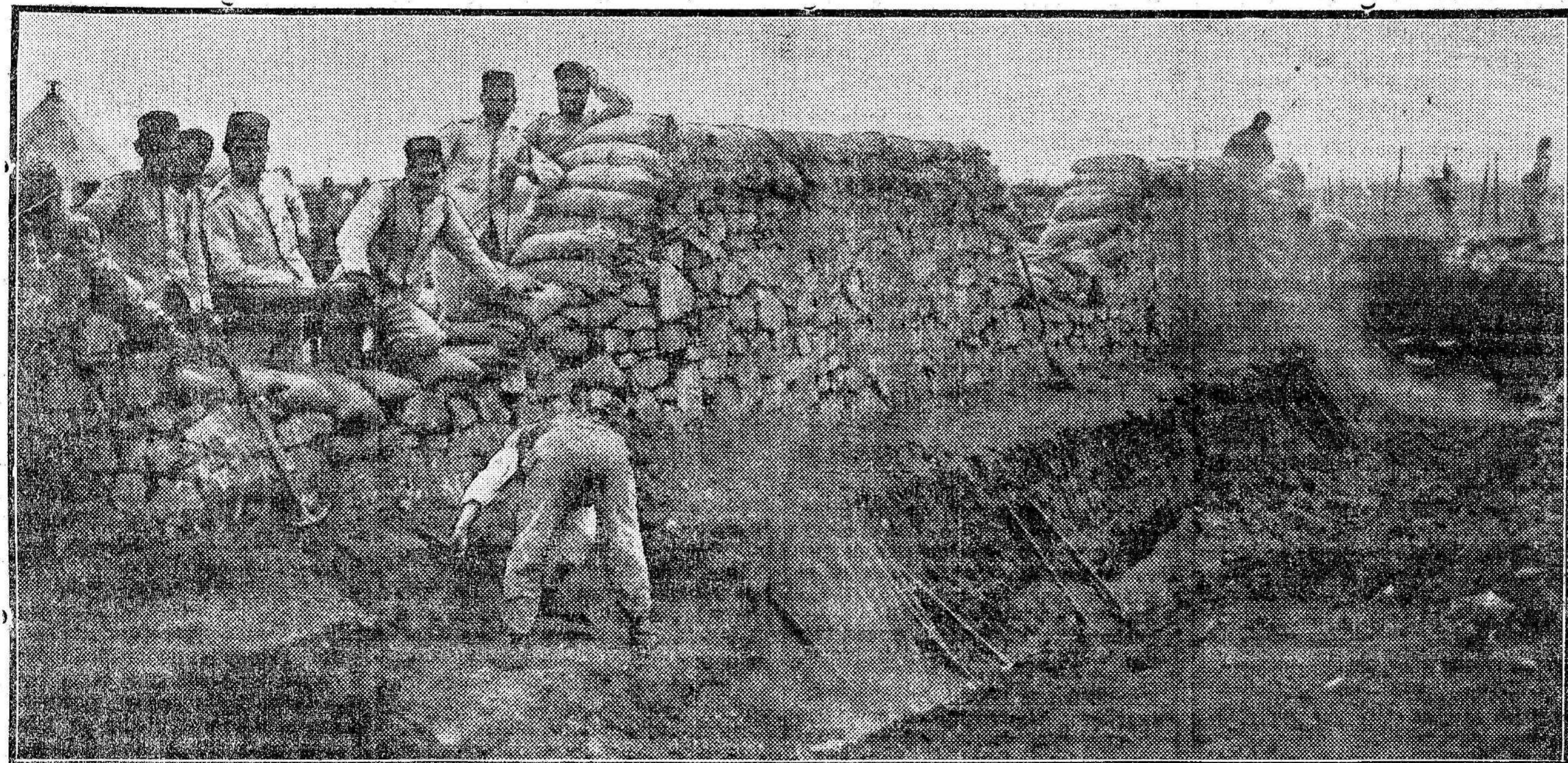
CONSTRUYENDO UNA TRINCHERA
