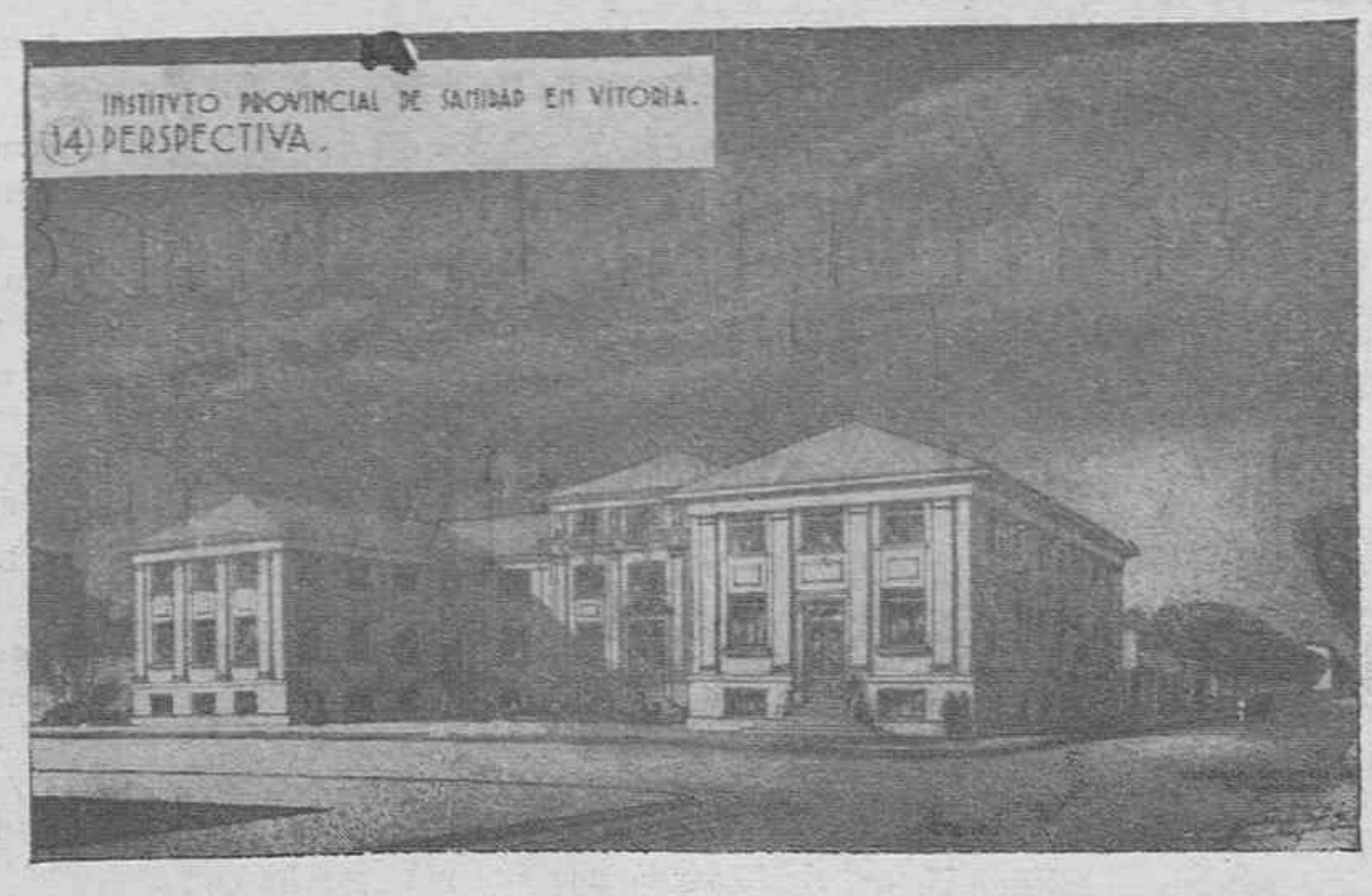
El nuevo edificio del Instituto Provincial de Sanidad que está terminándose de construir en la calle de Santiago y al que se refiere el artículo.
