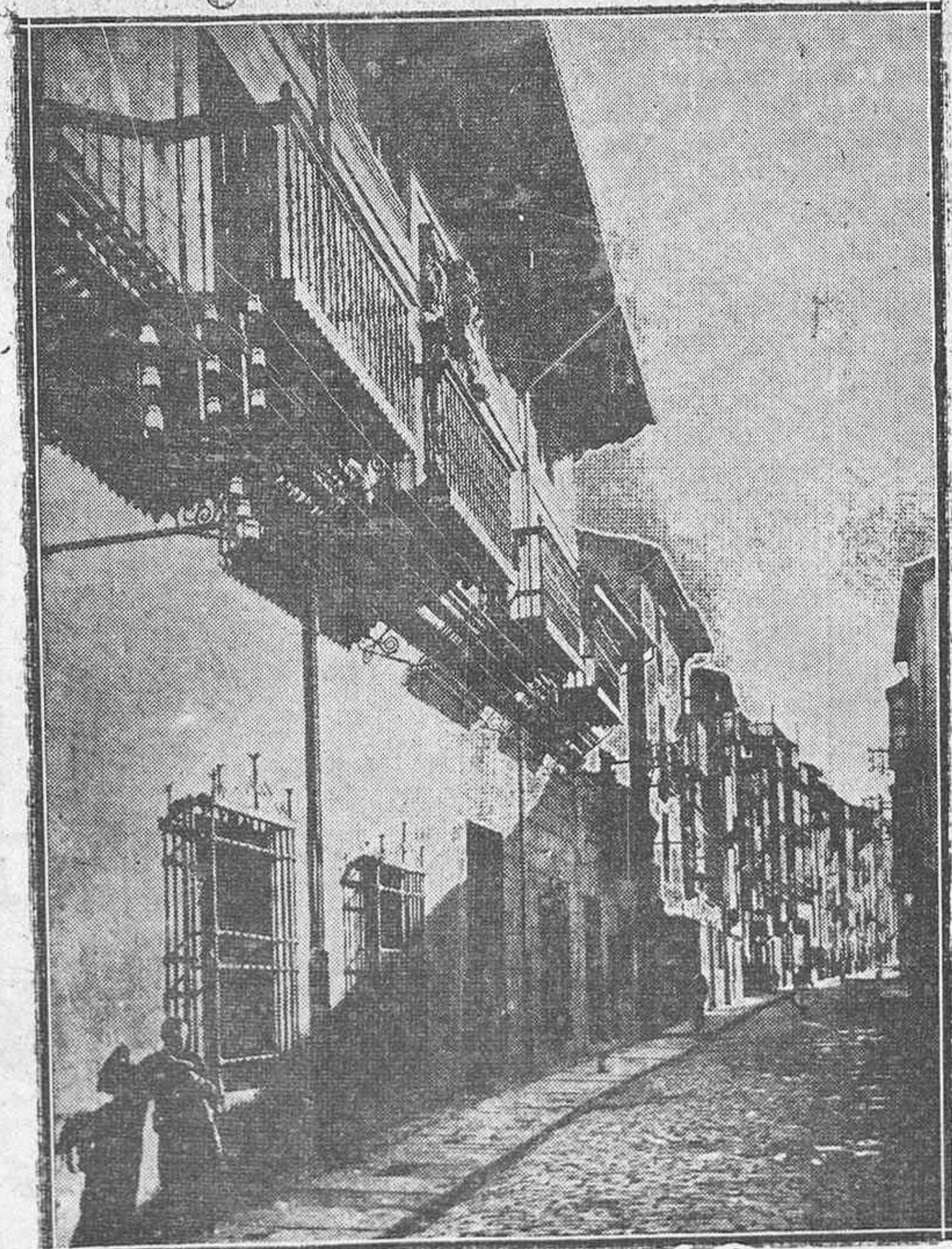
La típica calle de la Pintorería. En primer término, el Palacio de los Marqueses del Fresno. (De "Vida Vasca"). (Fotografiado PENSAMIENTO ALAVES)
