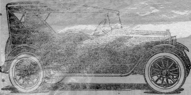
MOTOR. De cuatro cilindros fundidos en bloque, sección "L"; planta matriz única; 98 m/m de diámetro, por 114 m/m de carrera; 3 puntos de apoyo; culata del motor desmontable.
