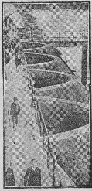
Presa de Bananeiros (Brasil), construida con pantalla de hormigón armado.
