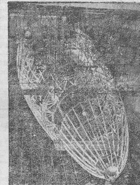
El cuerpo metálico de la aeronave durante su construcción.
