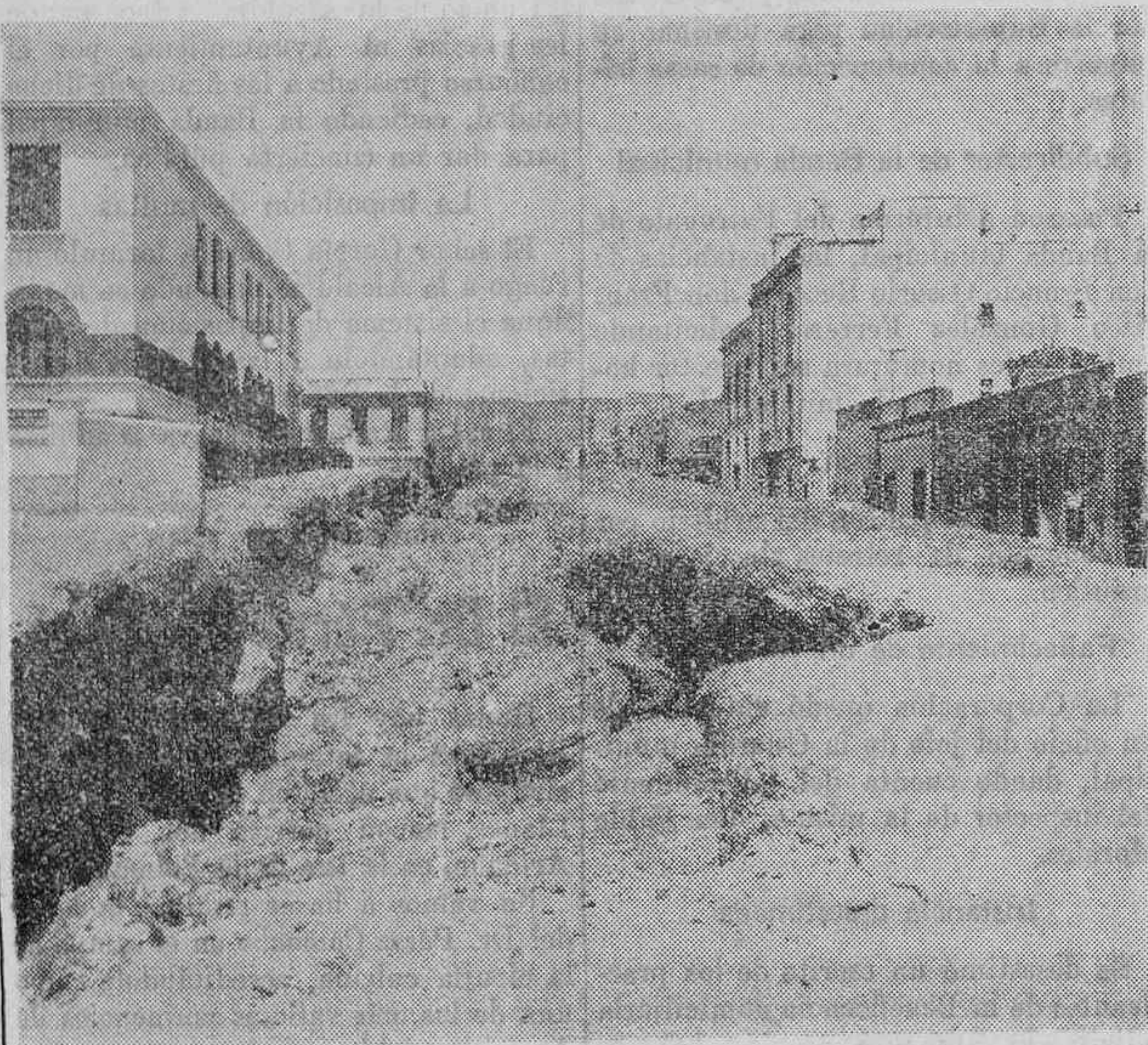
Un detalle de las «trincheras» del barrio de Duggi, donde han comenzado las obras de desmonte.
