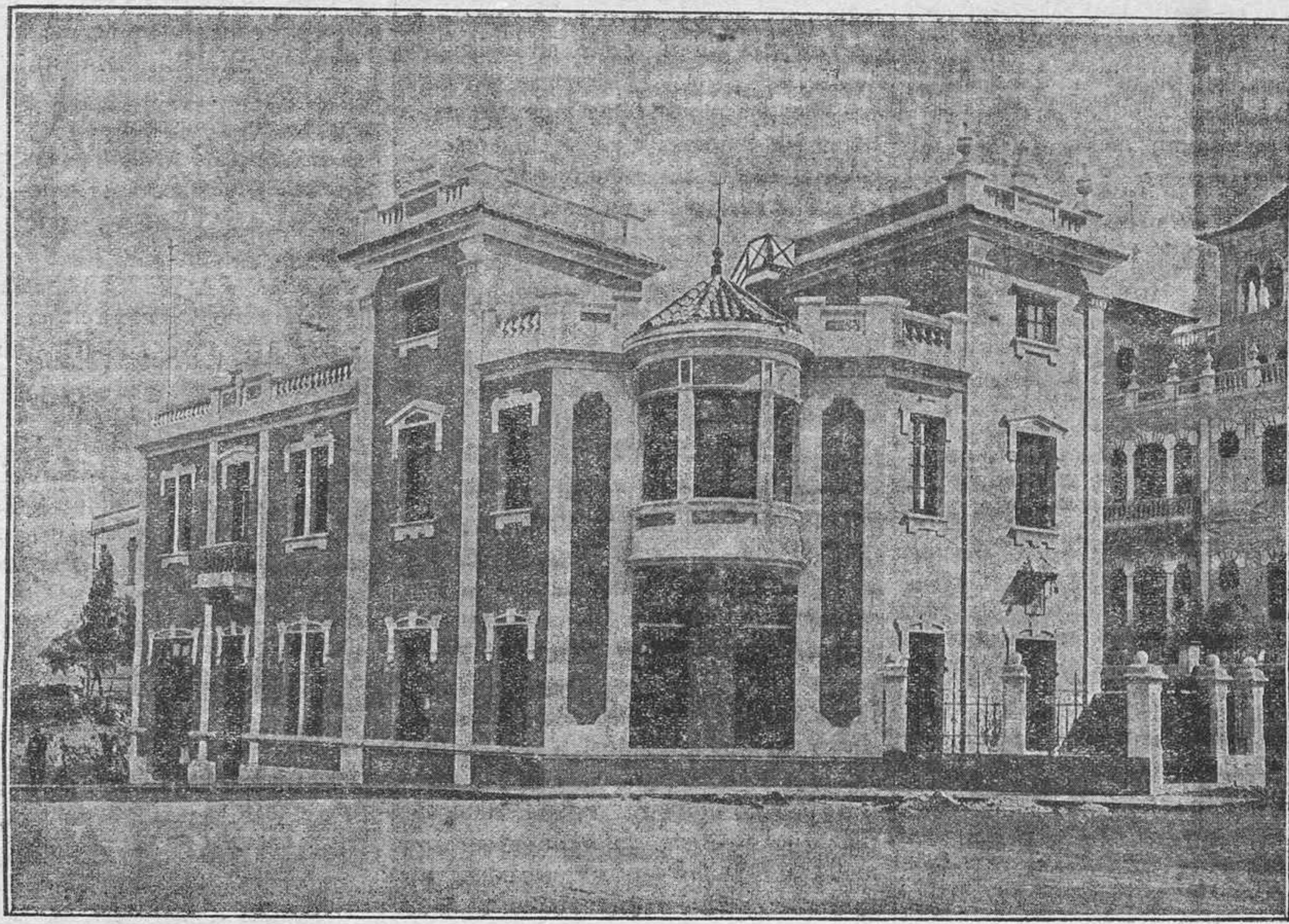
Hermoso chalet que el médico especialista en partos, don Adalberto Rodríguez López, ha construido en la calle de San Sebastián, frente al puente de Galcerán, para clínica y casa de maternidad. (Foto Benítez).
