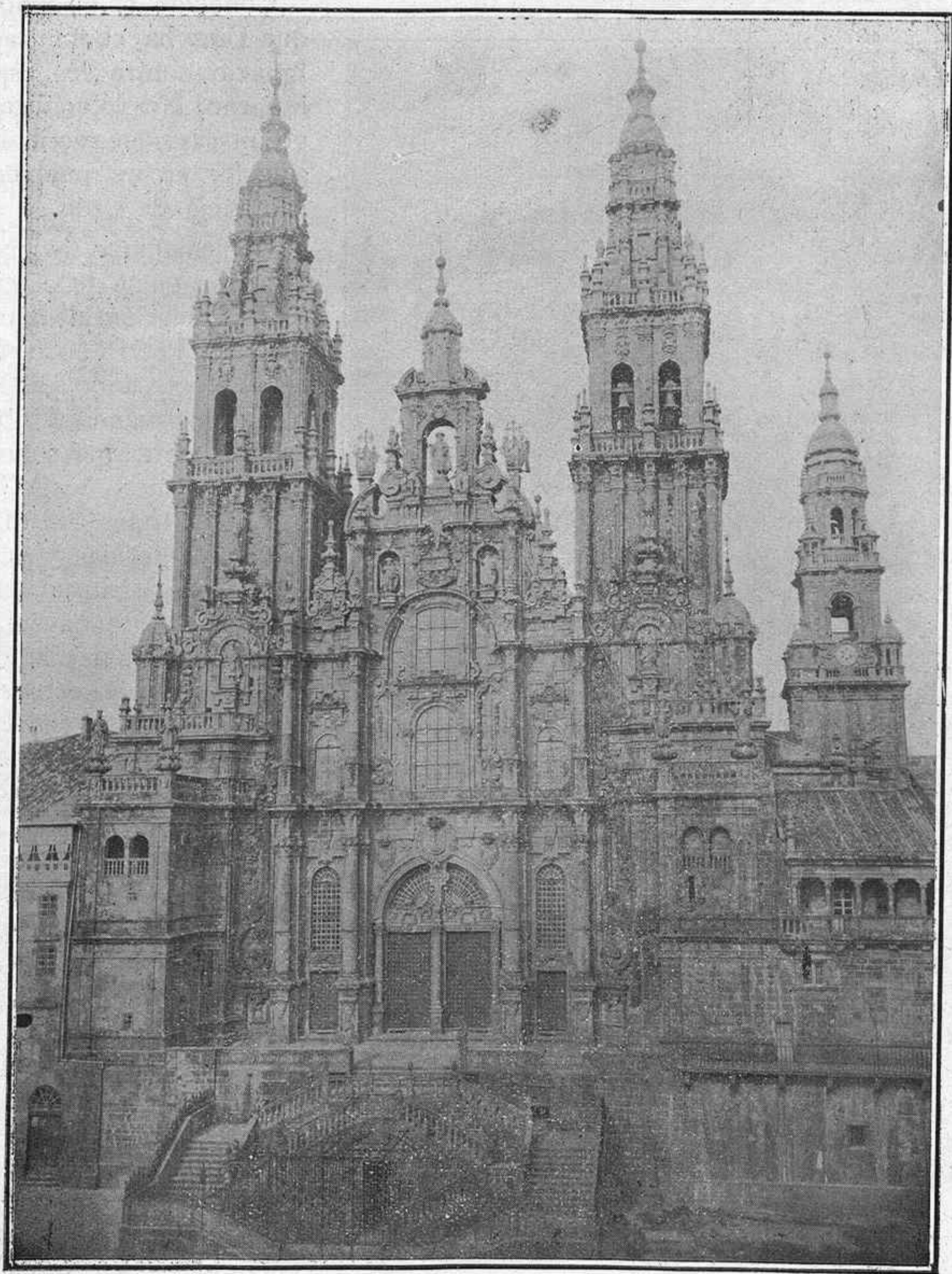
Fachada principal de la Catedral de Santiago.
