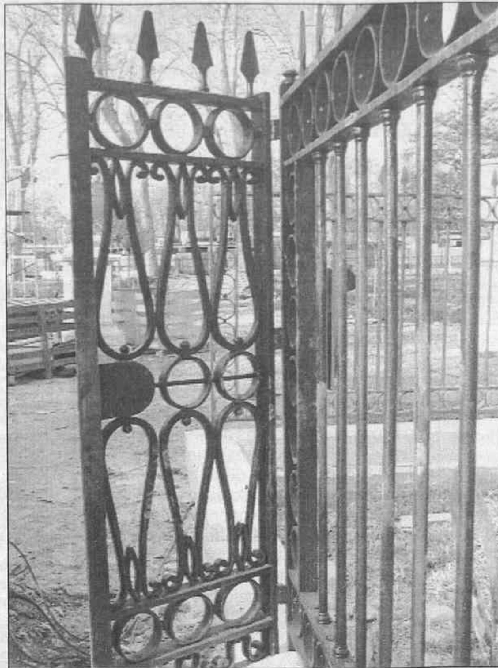
La verja de Isabel II. - Esta semana ha quedado instalada la verja que rodeará el pedestal y la estatua de la princesita Isabel en su remozado jardín. Dos meses ha tardado Famvag en eliminar las zonas más deterioradas del hierro, sobre todo de la parte inferior y añadir las puntas de lanza que le faltaban en el remate superior. La verja se alza sobre la blanca piedra de Colmenar que ha canteado una empresa de Madrid.
