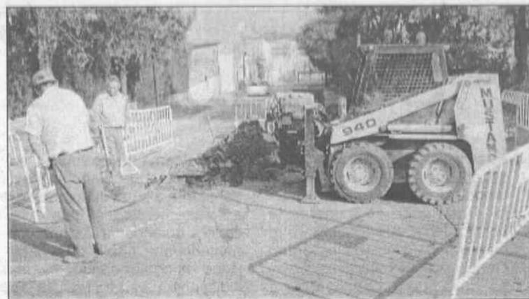
**El colector se hundió.**- A más de un conductor dio un verdadero susto el socavón que se empezó a formar junto a la tapa de una alcantarilla en la carretera de Ontígola. Lo rellenaron con asfalto pero el hueco siguió creciendo y al final los servicios municipales tuvieron que abrir para comprobar que un colector en desuso había cedido. Después de conectar el colector a la nueva red se ha tapado con tierra para que se compacte con el paso de vehículos, y después se asfaltará.
