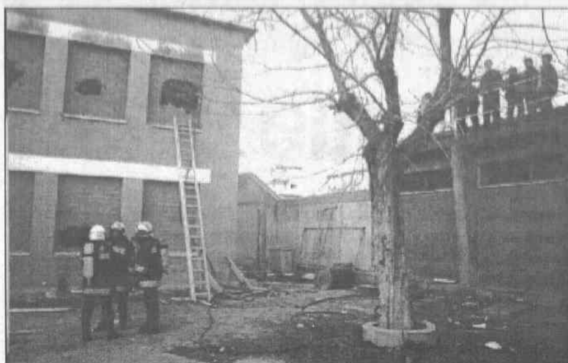
Los bomberos tuvieron que agujerear las ventanas tapiadas del viejo edificio para sofocar el incendio. Al lugar también acudieron dotaciones de Policías Nacional y Local, Protección Civil y Cruz Roja.
