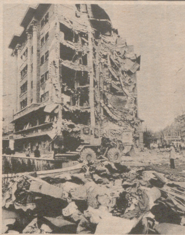
Un gran tractor limpia de escombros las aceras de una importante calle de la capital rumana, frente a un edificio gravemente dañado por el terremoto del pasado día 4.
