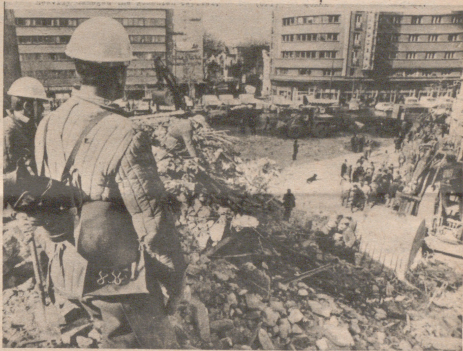
Continúan las labores de rescate en los escombros de los edificios derruidos situados en el centro de la capital rumana, que sufrió la sacudida del terremoto que asoló Rumanía.
