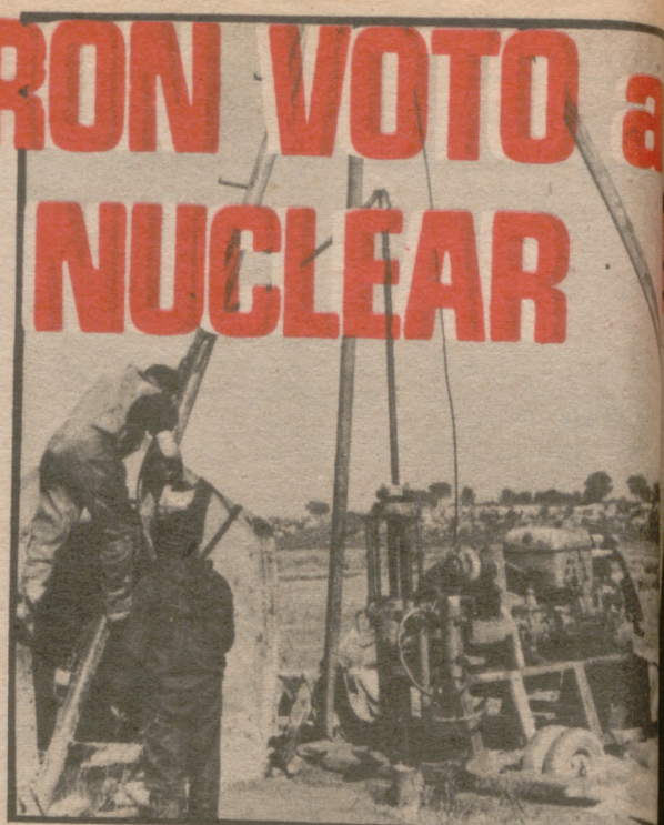
Este es uno de los quince sondeos practicados en "Partido Moros" en el término municipal de Escatrón, donde se instalará la central nuclear. De hacerse, se hará en otros términos del municipio. (Foto, García Luna)
