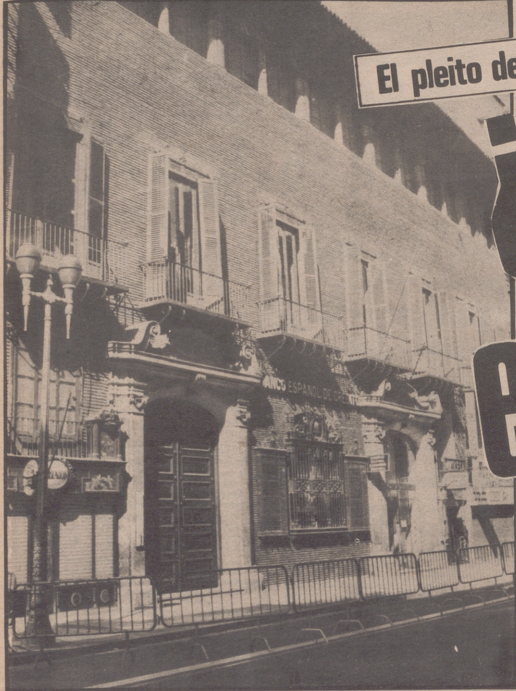
Con cierre absoluto para los traséúntes, ha sido cercada también toda la acera y el carril de autobús
