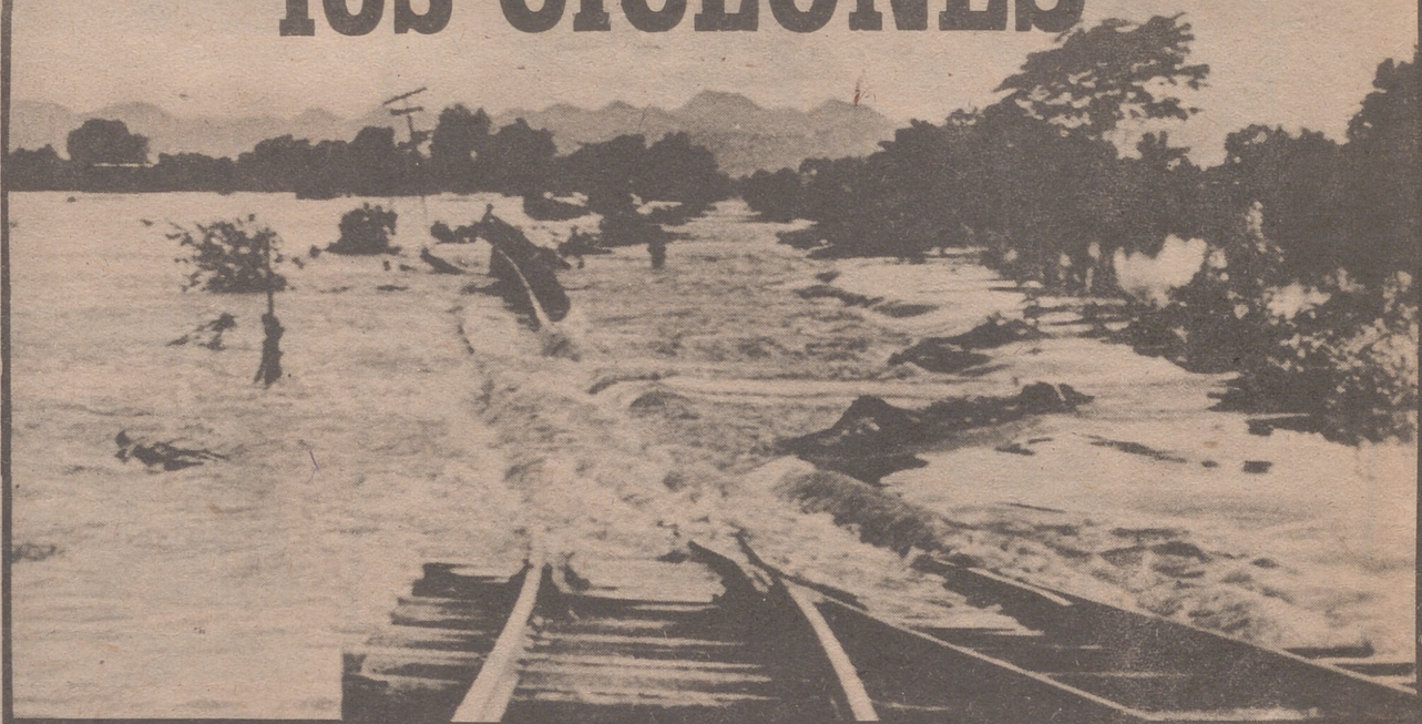
Los desastres ocasionados por el "Fifi" pudieron ser evitados a un coste inferior a los daños que produjo. (Foto Efe - Fiel)
