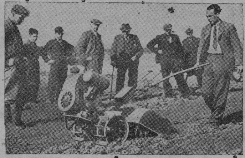
Esta máquina inglesa realiza indistintamente las operaciones de arar, excavar, layar y esparcir abonos
