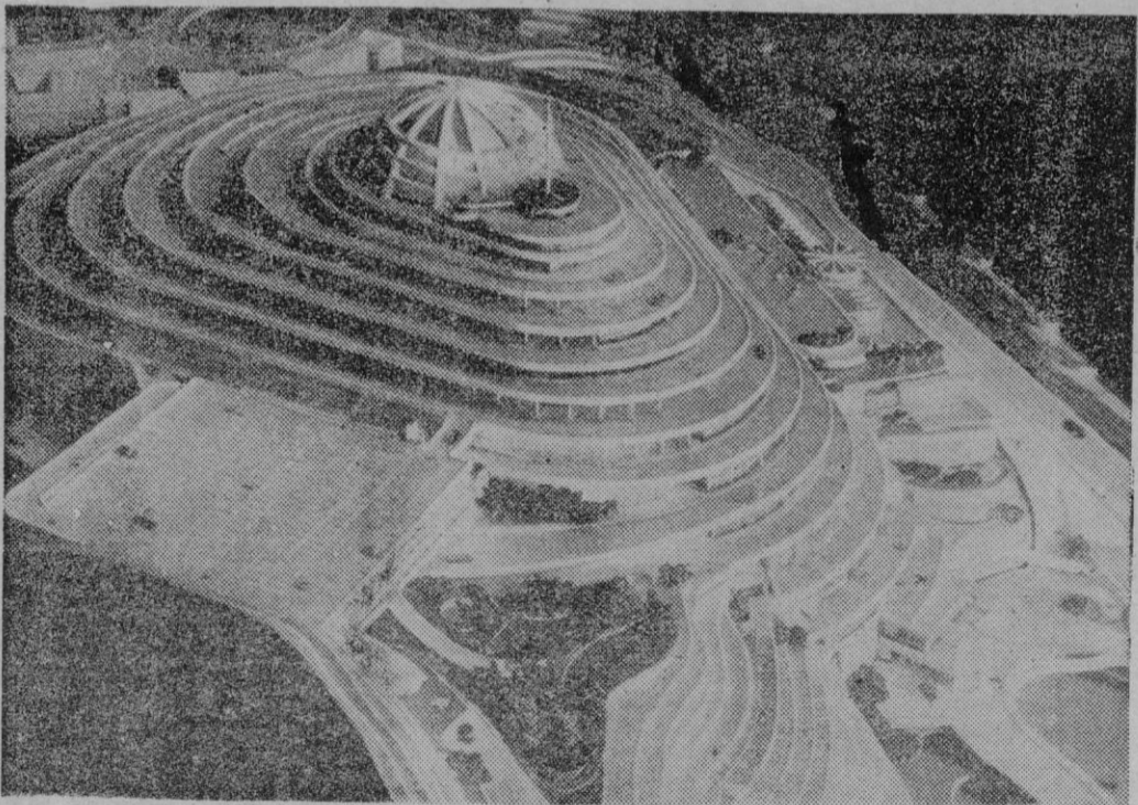
Esta es la maqueta del «Elicoide de la roca Tarpeya», en Caracas, que se encuentra en plena construcción. Por la magnitud de la obra, que convertirá en un solo centro un cerro de 101'940 metros cuadrados, puede decirse que constituye una de las construcciones más originales del mundo.—F. Cifra)
