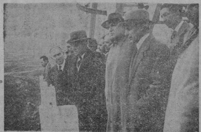
El Conde de Vallellano, acompañado del Gobernador Civil, Marqués de la Valdavia, ingeniero de la Confederación Hidrográfica del Duero y otras personalidades, durante su visita a las obras del nuevo pantano de Aguilar de Campoo.—(Foto Cifra Gráfica)
