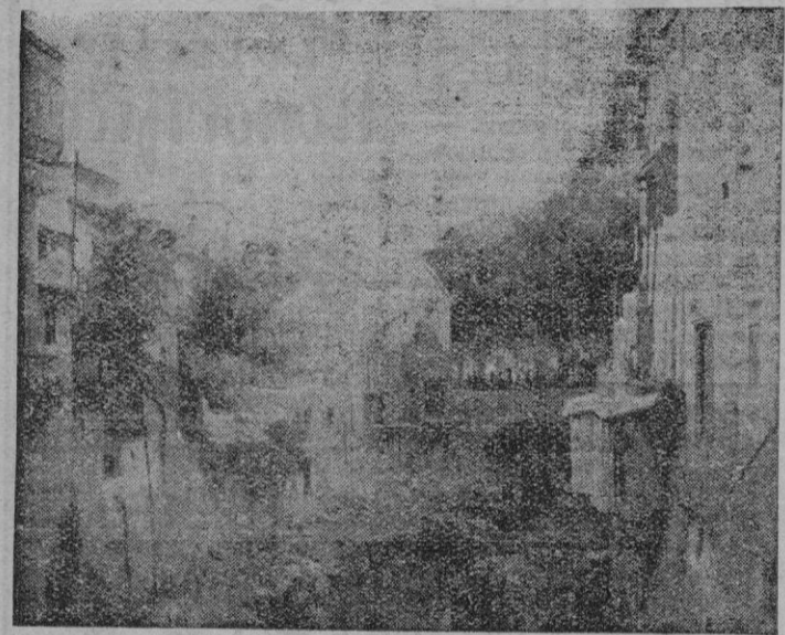
Una de las reformas más importantes de Sóller es la cubrición de este torrente, cuyas obras ya han comenzado
