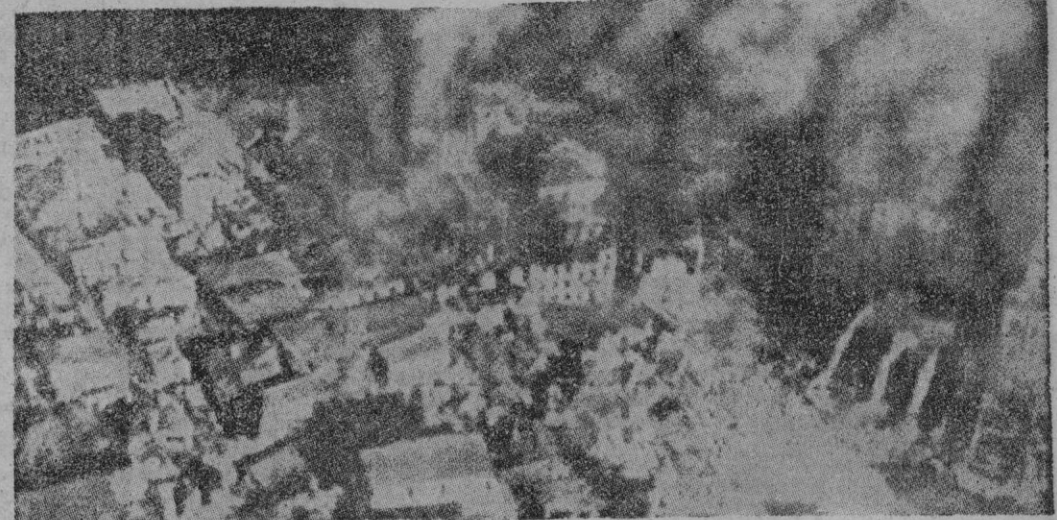
La isla de Zakynthos, conmovida por los terribles terremotos que han asolado Grecia, está en ruinas. Esta fotografía fue tomada anteaer desde el aire. El piloto informó: "Zakynthos era una enorme masa de llamas visibles desde varias millas. Manzanas enteras aparecen en ruinas, como si hubieran sido destruidas por minas o bombas. La perspectiva de esta ciudad era aun más horrible que la que mostró Hiroshima después de la bomba atómica."
