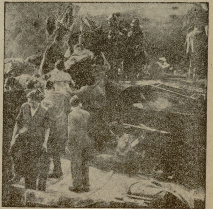
Harrow. — Una vista de la estación de Harrow y Wealdstone, donde chocaron tres trenes, durante los primeros trabajos de salvamento de las víctimas. — (Foto Cifra-U. P.)
