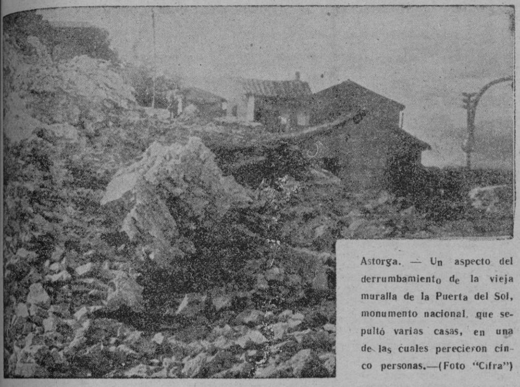
PRIMERA FOTO DEL DERRUMBAMIENTO DE LA VIEJA MURALLA DE ASTORGA
