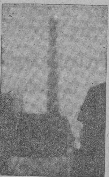
La chimenea de la fábrica Ribas que quedó hendida longitudinalmente, ocasionando numerosos destrozos.
