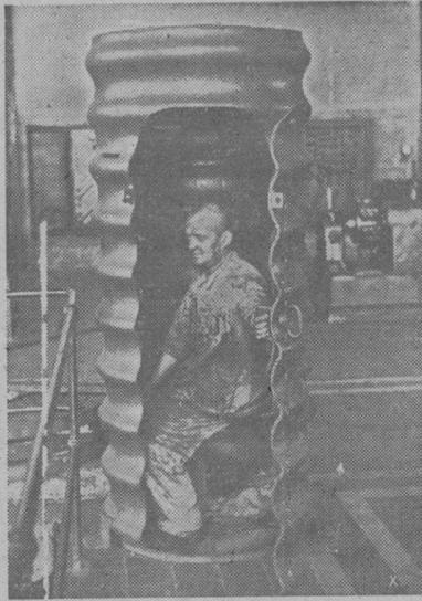
Refugio individual que se ha instalado en muchas fábricas alemanas para los trabajadores que no tienen ocasión de refugiarse en los colectivos. Su construcción permite seguir controlando los lugares de trabajo importando máquinas, etc.
