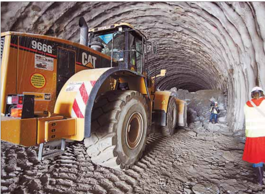
Una máquina excavadora retira escombros del interior del túnel de la vertiente segoviana, donde se han horadado ya unos 300 metros. / FERNANDO PEÑALOSA
