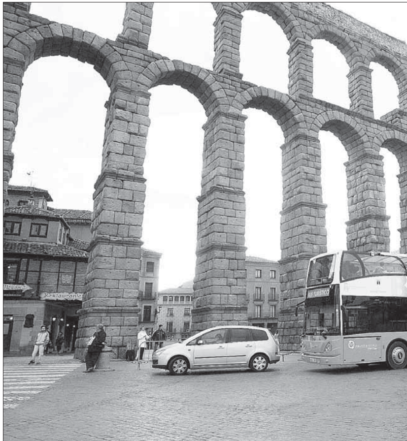
El Acueducto cuenta con 20.400 sillares, distribuidos en 10 pilares y 166 arcos. En su parte más alta mide 28,10 metros/f.F.P.
