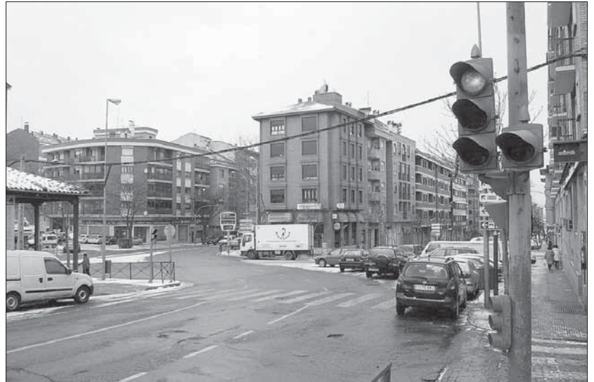
Las obras de mejora de las travesías podrían comenzar con la nueva rotonda al final de José Zorrilla. JUAN MARTÍN
