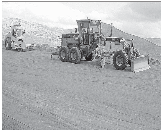
Varias máquinas explanando la zona donde irá el nuevo peaje de San Rafael./F. P.
