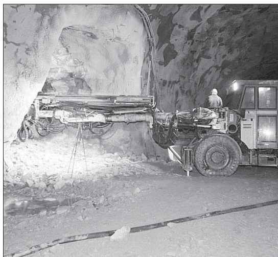
Una máquina realizando la excavación de una galería transversal./F. P.
