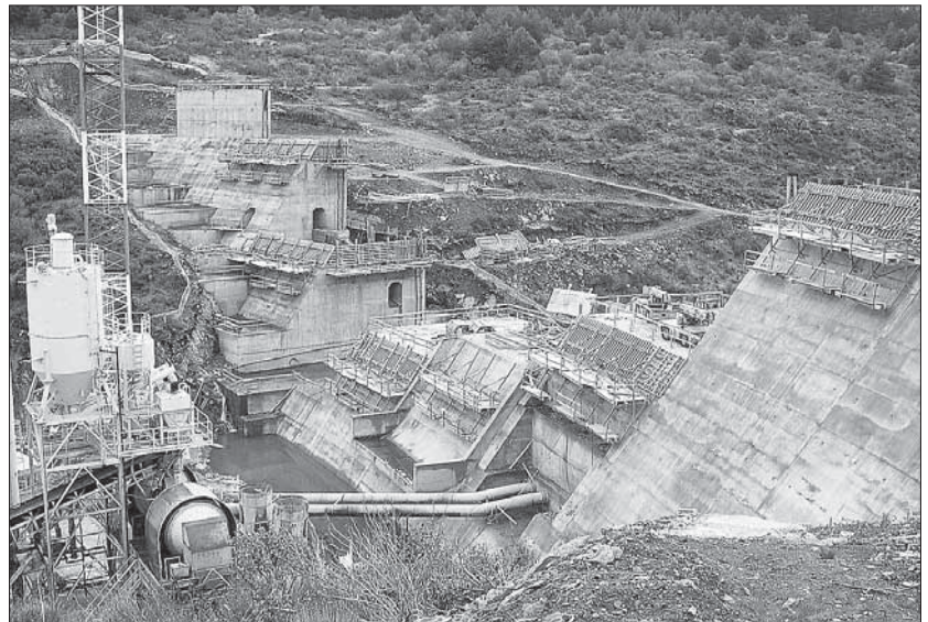
Las obras de la presa del Ceguilla fueron puestas como ejemplo de gestión. /J.H.
