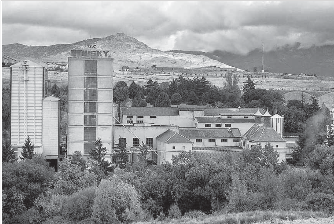
Imagen exterior de la fábrica de DYC en Palazuelos de Eresma, donde va a comenzar a producirse la ginebra Larios. / JUAN MARTÍN
