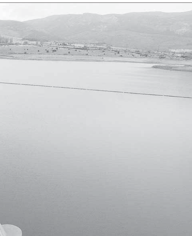
Potabilizadora del agua del Pontón Alto debido al bajo nivel que presenta el embalse/PEÑALOSA
