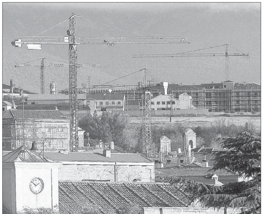
La pujanza del sector de la construcción había favorecido la extensión de los casos de extorsión /KAMARERO
