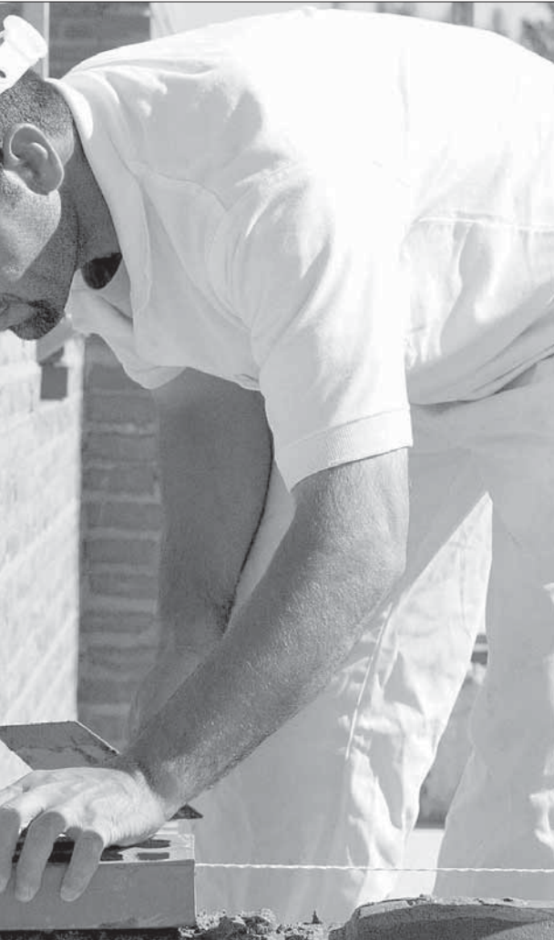
Un trabajador de la construcción coloca ladrillos en una obra. / ICAL
