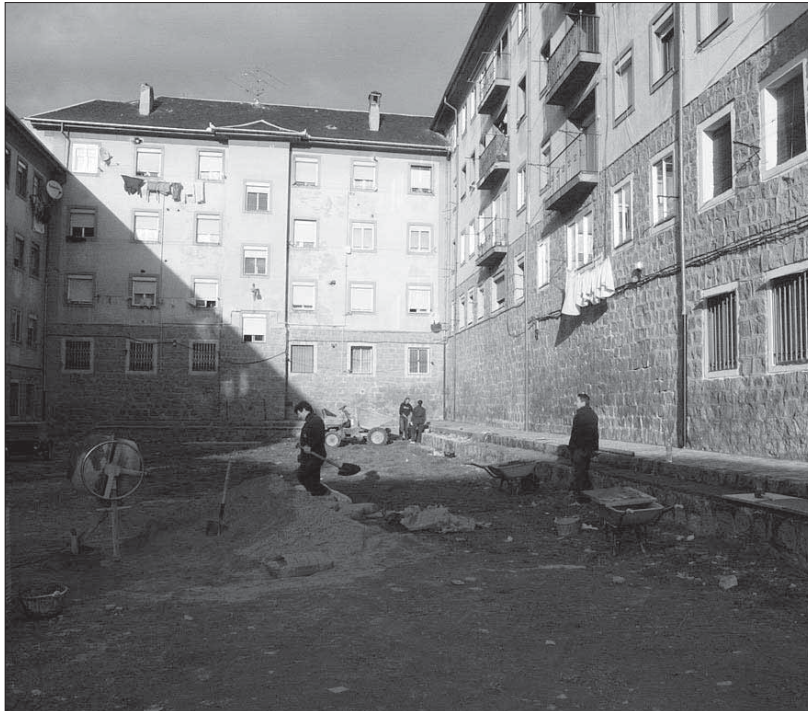
Los trabajos realizados en uno de los patios servirán para ver las necesidades globales
