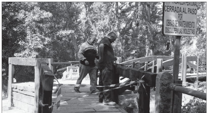
Los operarios municipales iniciaron ayer las tareas de arreglo de la pasarela
