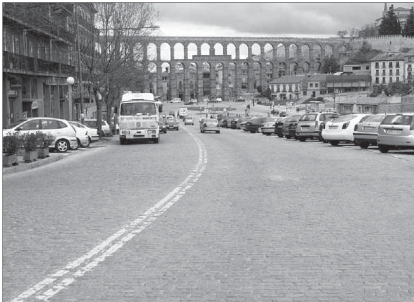
El parking , de tres plantas, discurrirá bajo la avenida de Padre Claret
