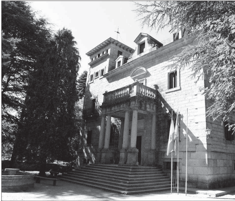
El albergue de San Rafael cuenta con 55 plazas y está ubicado en un edificio de piedra
