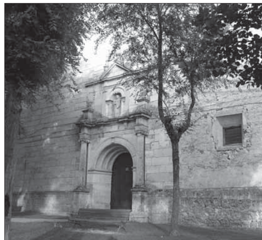
Convento de Santa Clara en la zona sur de la villa
