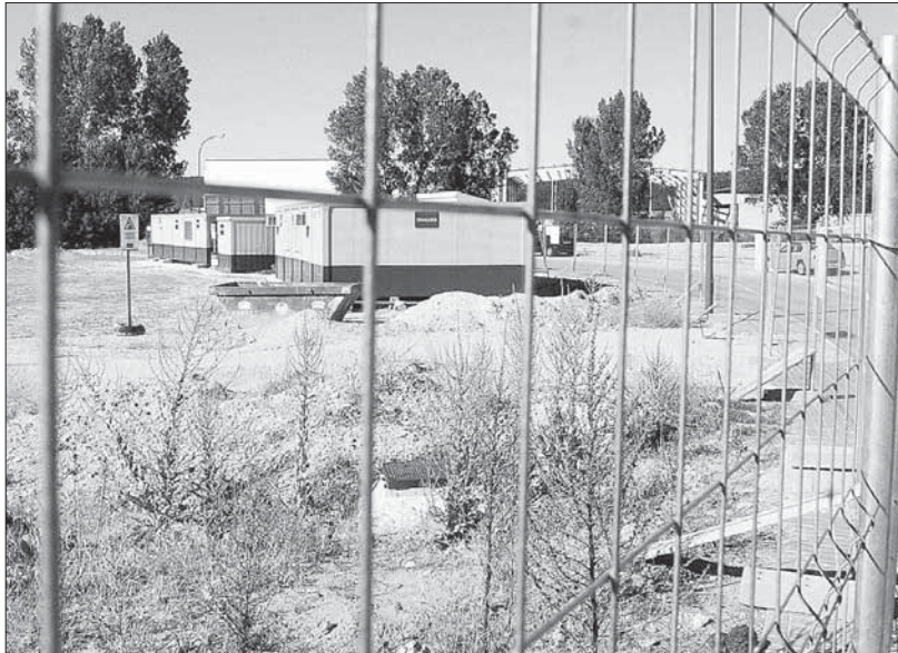
Los primeros trabajos han comenzado con el vallado y el replanteo de la parcela
