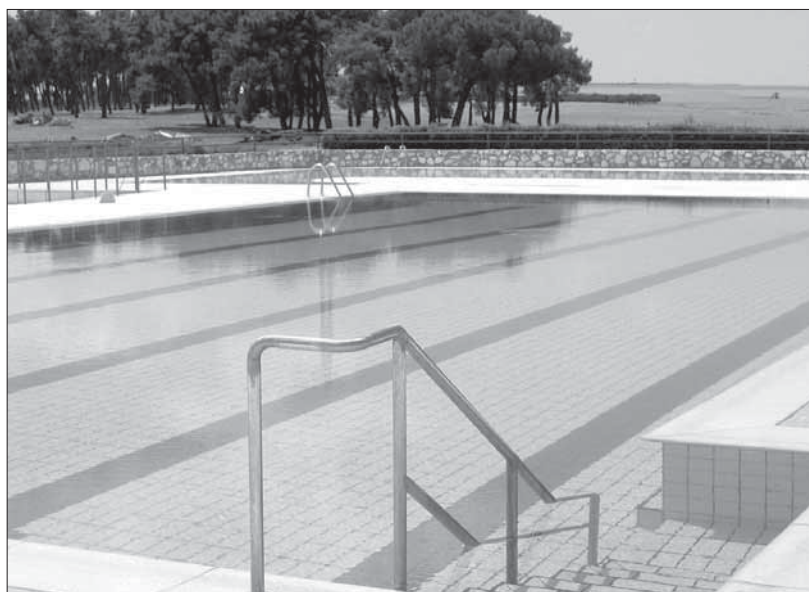
Estado actual de la piscina municipal de Mozoncillo
