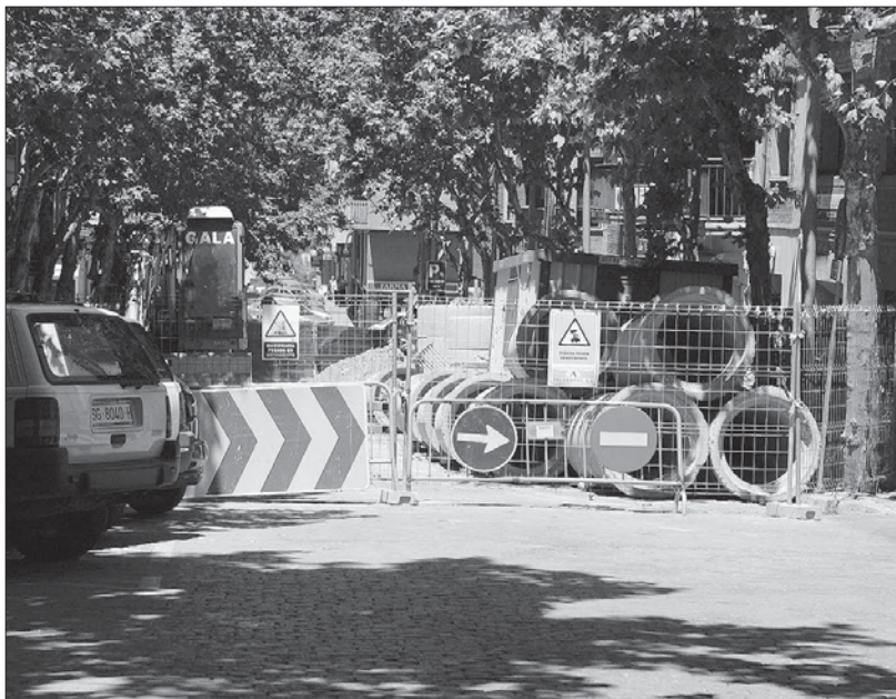
Los trabajos han obligado a cortar parcialmente el tráfico por la calle de Santo Tomás
